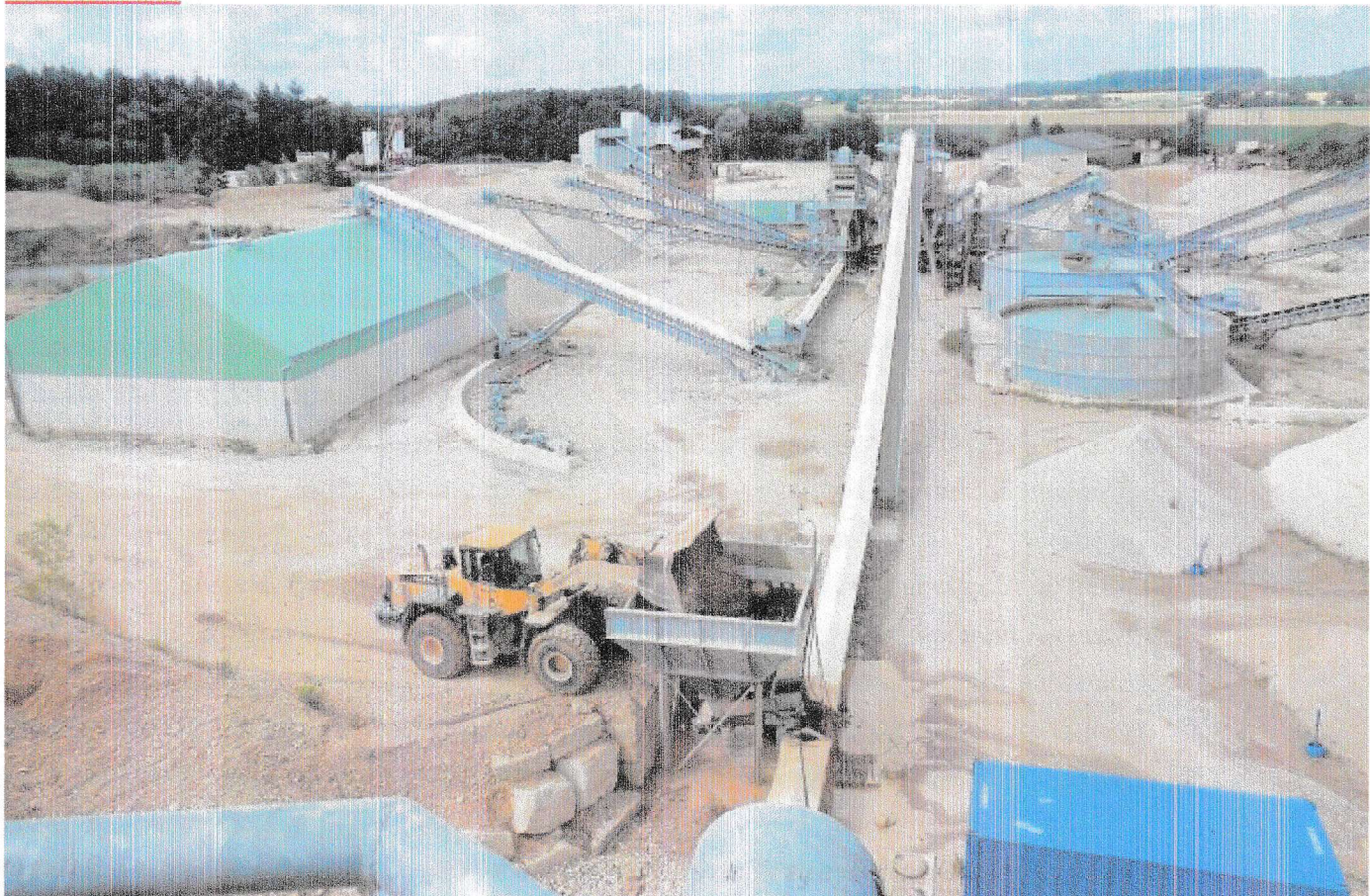
- Vue d'ensemble de l'installation.
